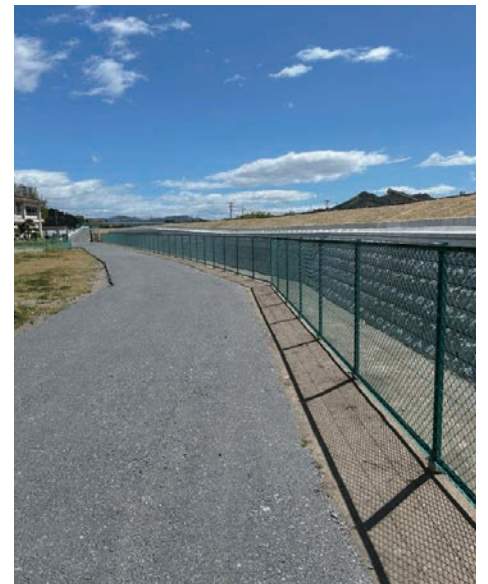
護岸工事による学校南側の堤防とフェンス
