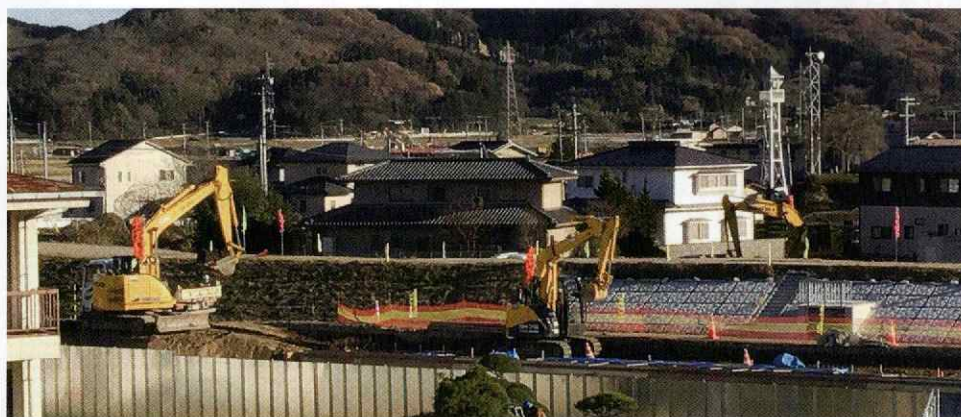
護岸工事の様子
